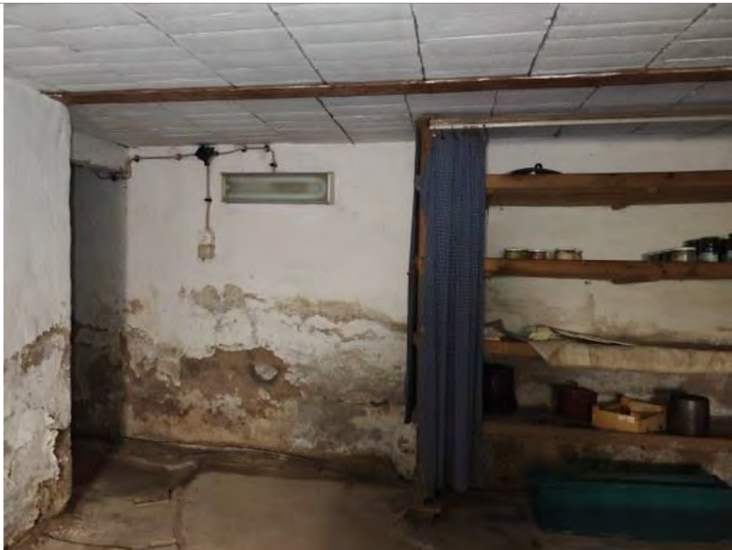
dritter Kellerraum mit Blick in Richtung Norden
