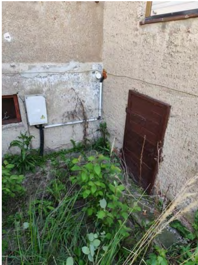
direkt gegenüber dem Schuppen mit den Öltanks befindet sich noch eine kleine Kammer
