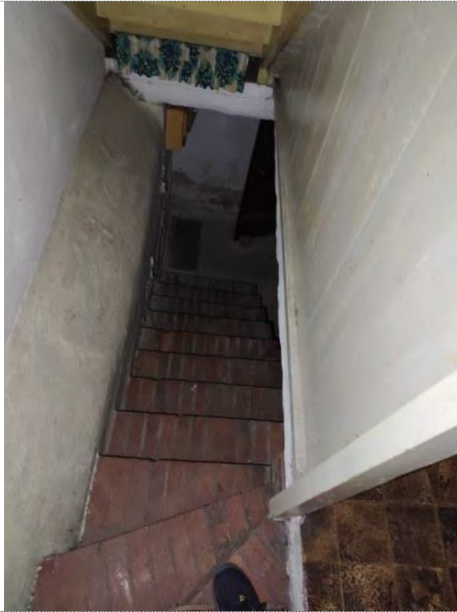
Kellertreppe in Blickrichtung Südwest
