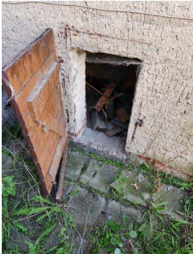
Blick von außen in die Kammer mit Blick in Richtung Südost
