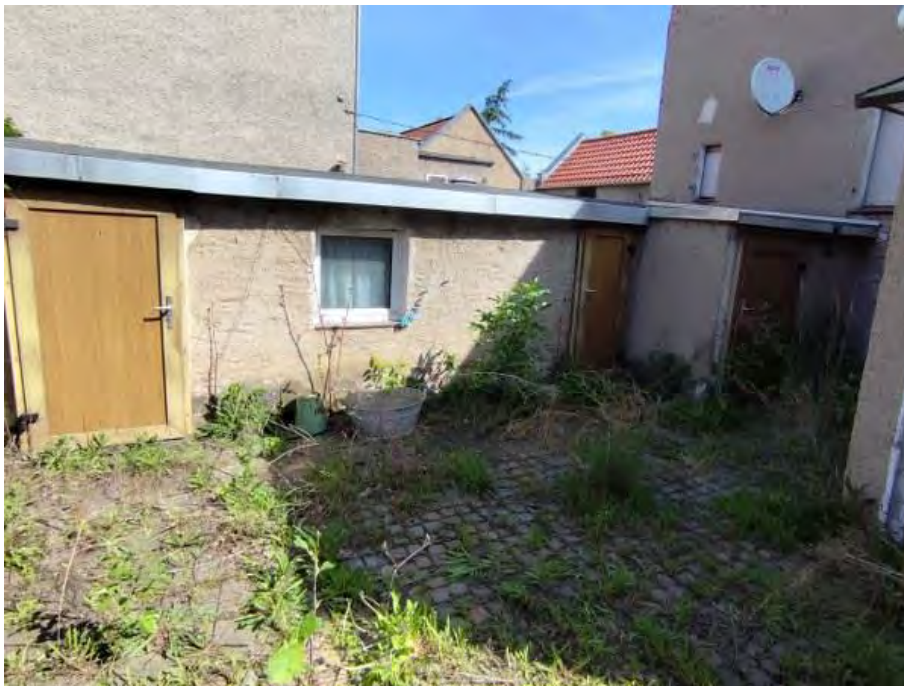
rechts angrenzend befindet sich ein Nebenglass mit drei Schuppen; Blickrichtung Nordwest
