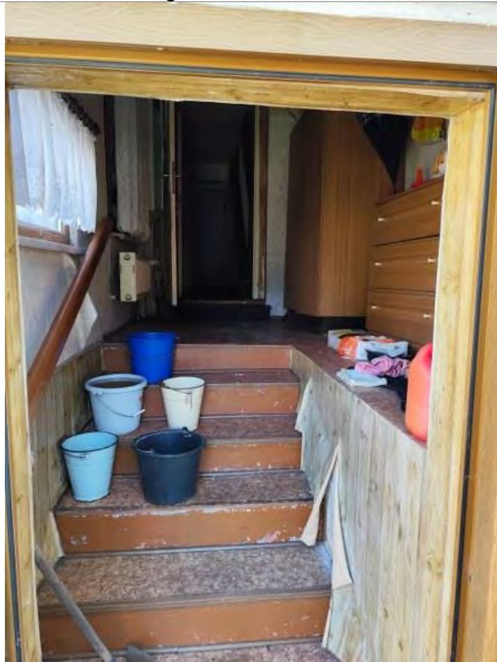
Blick in den Vorraum Richtung Nordost
