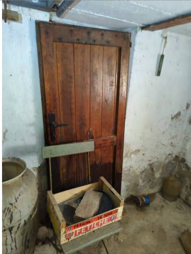
Zugangstür in den Garten
