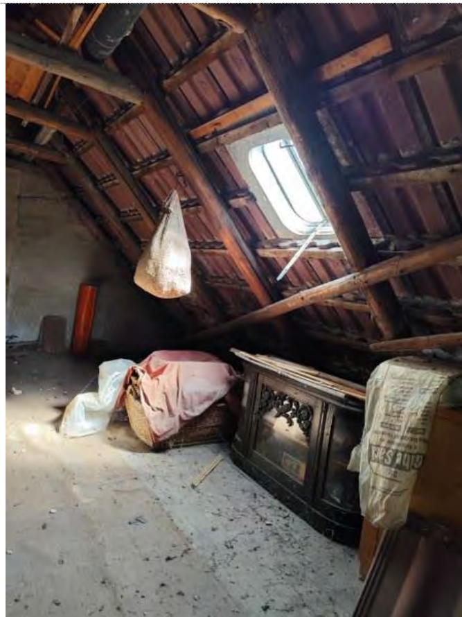
Blick nach Nordosten in den Dachboden
