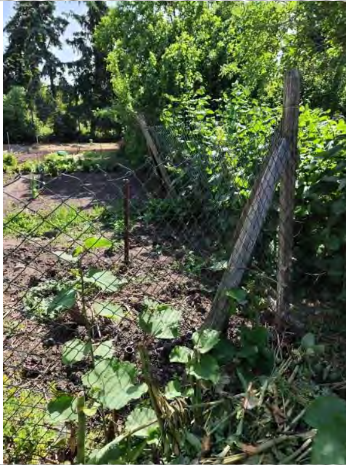
Blick auf den beschädigten Zaun (rechts vom Zaun – der zweite Teil des verwilderten Gartens)
