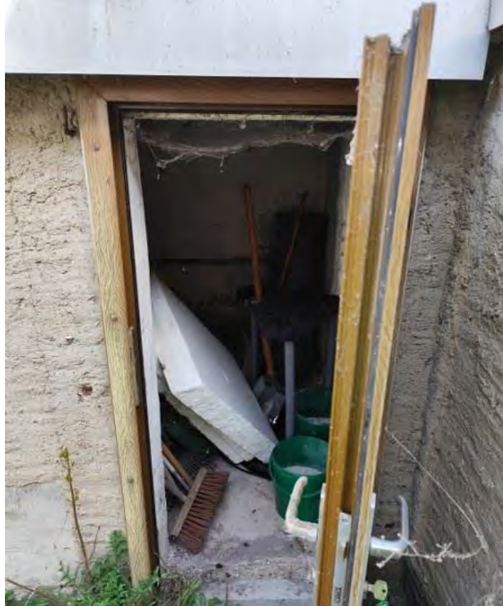
Blick vom Innenhof in den linken Schuppen vom vorherigen Bild
