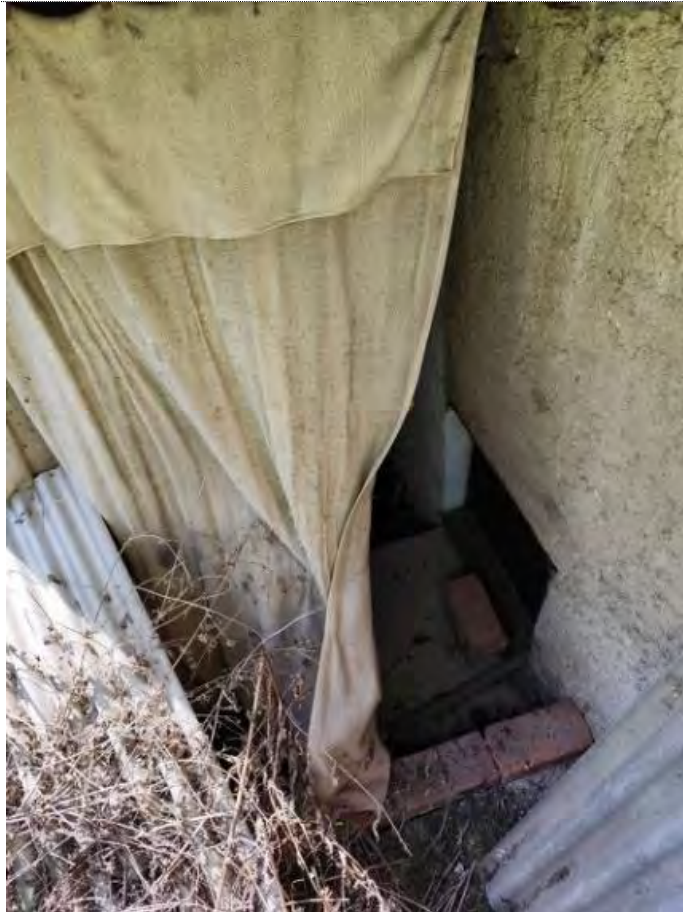
Blick Richtung Treppe vom Garten in den Keller
