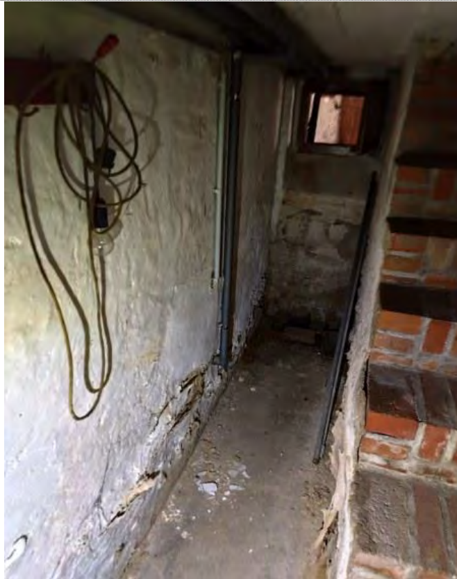
Blick vom unteren Ende der Kellertreppe in eine schmale Nische Richtung Nordost; hinter dem Fenster ein weiterer Kellerraum
