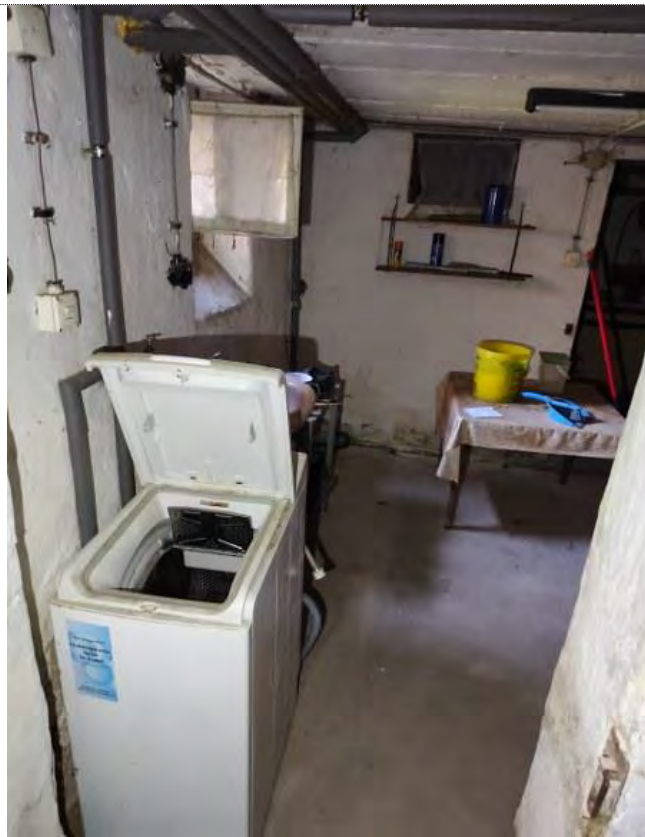
Blickrichtung Nordwest von der Kellertreppe in einen Kellerraum; rechts neben dem Fotostandpunkt befindet sich die Nische; Fenster im Kellerraum wurde verschlossen; links in der Ecke der Wasserzähler
