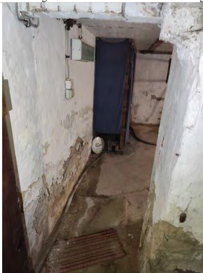
Blick in den dritten Kellerraum
