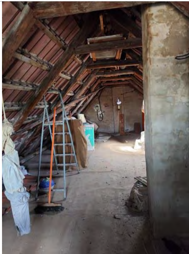
Nordwestblick in den Dachboden
