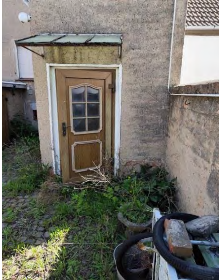
Blick vom Innenhof auf die Eingangstür des Wohnhauses; rückwärtig befindet sich das kleine Nebenglass und links vom Fotostandpunkt ist das Nebenglass mit den drei Schuppen
