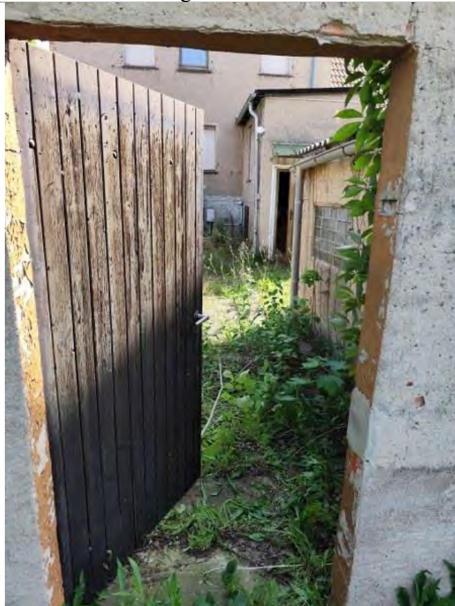
Tür zum Innenhof mit Blick in Richtung Nordost
