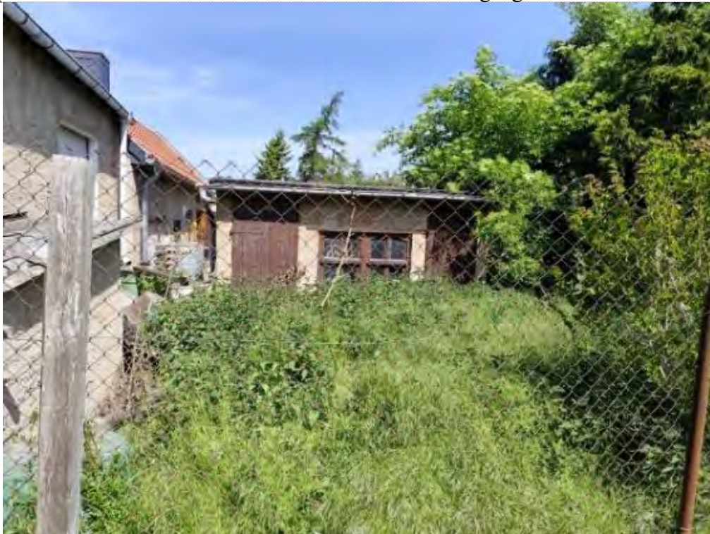
Blick vom Nachbargrundstück auf den verwilderten Garten und den Schuppen in Richtung Nordwest
