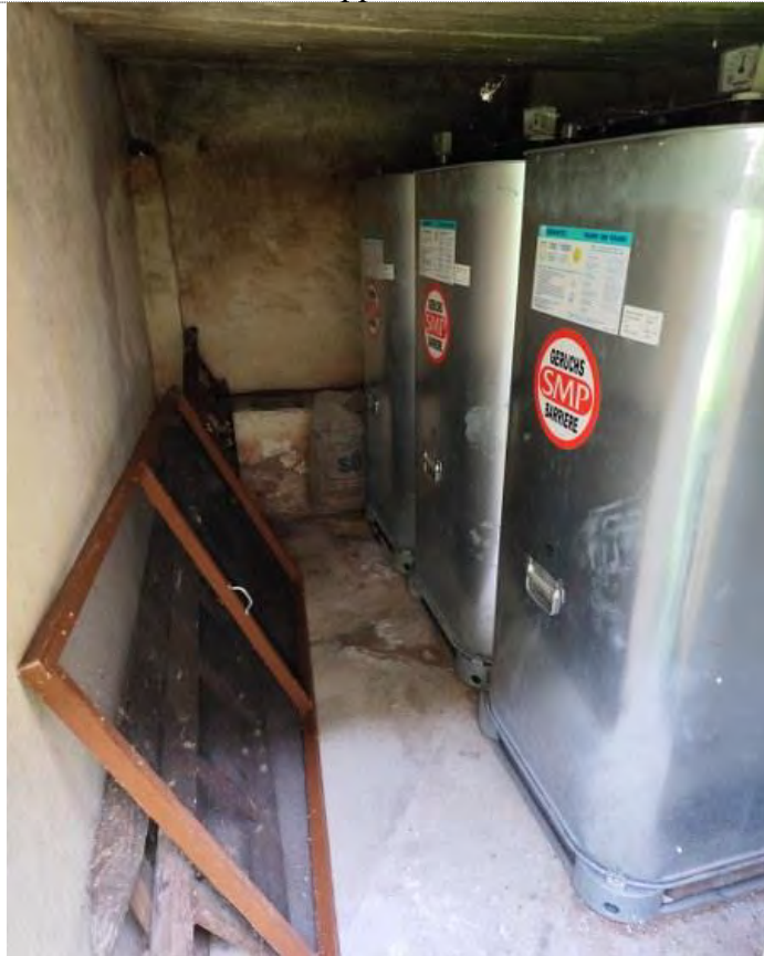
Innenansicht des Schuppens mit Blick nach Nordwest
