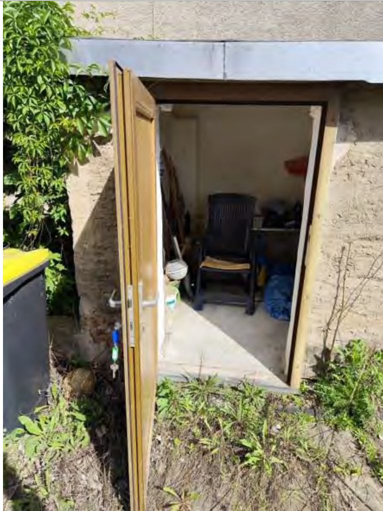
Blick in den ersten kleinen Schuppen vom Nebenglass - Blickrichtung Nordwest
