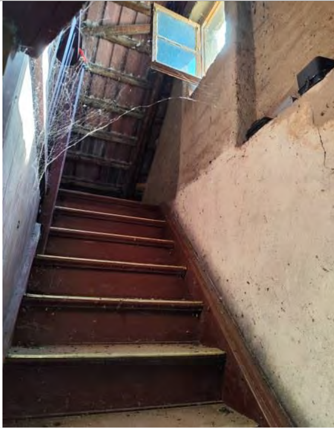
Blickrichtung Nordost an der Treppe entlang zum Dachboden hoch
