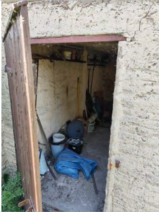
Sicht vom Innenhof in das kleine Nebenglass in Richtung Südwest
