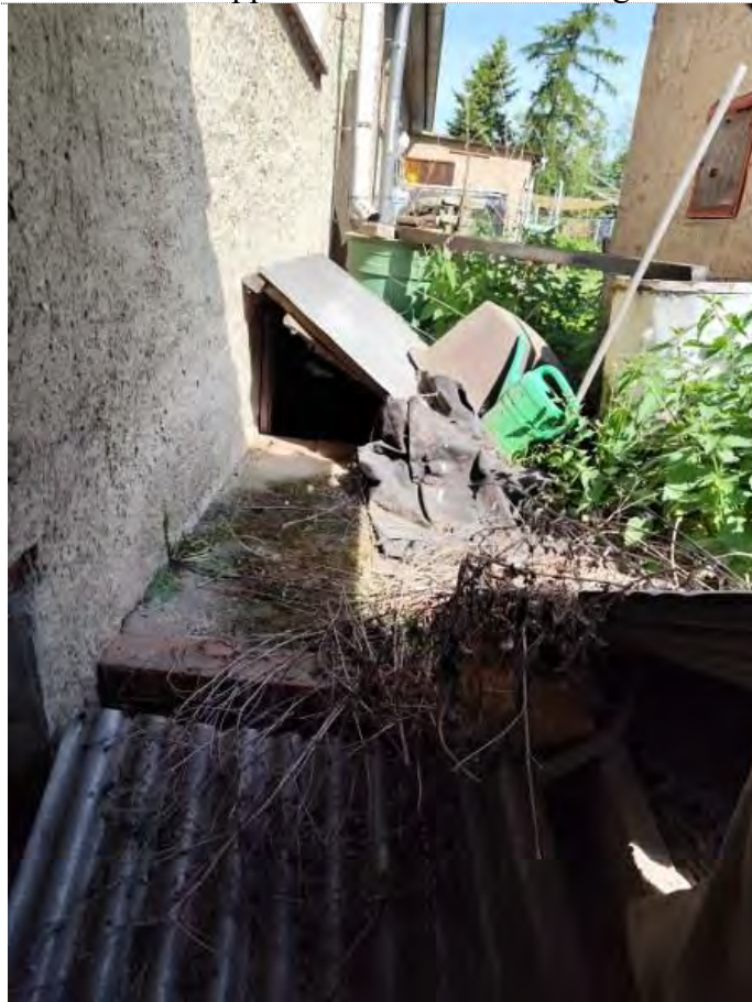
Blick nach Nordwest von der Treppe zum Garten; rechts noch ein Schuppen
