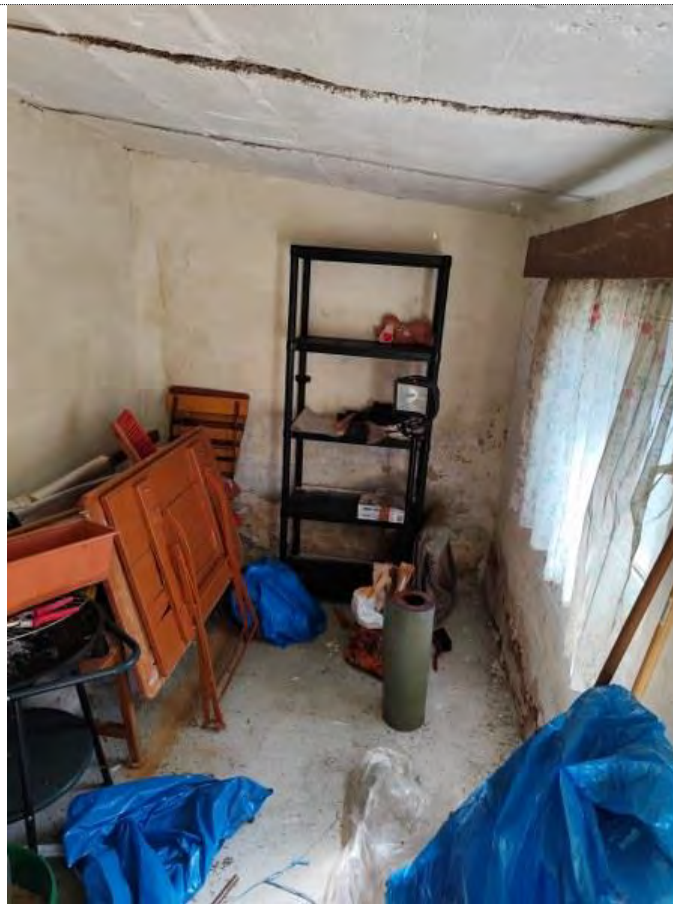
Innenansicht des ersten Schuppens Richtung Nordost
