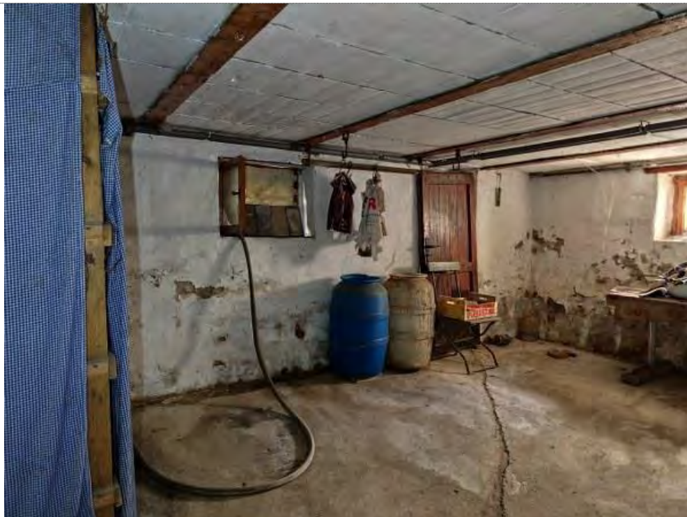
dritter Kellerraum mit Blick in Richtung Südost; Tür rechts im Bild führt in den Garten u. ist der einzige Zugang in diesen
