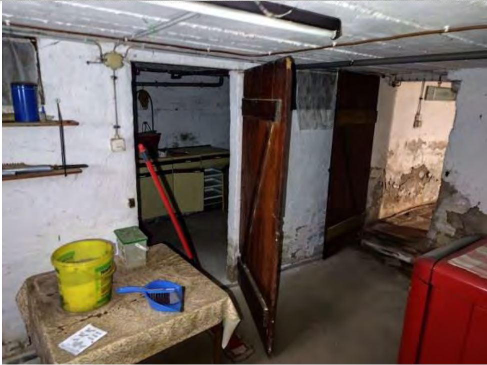
Blickrichtung Norden; links unten neben dem Tisch ist der Wasserzähler, mittig sowie rechts im Bild weitere Kellerräume
